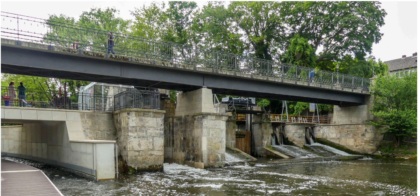
Das sanierte Petriwehr von der Nordseite. Foto: Hartmut Klinkmann
